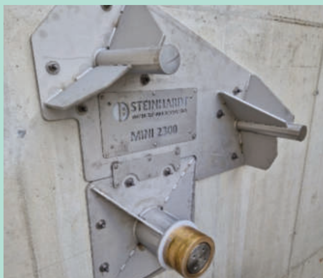
Drehauflager der HydroSlide® Abflusssteuerung – HRB Rettenbach, Sölden, Tirol
